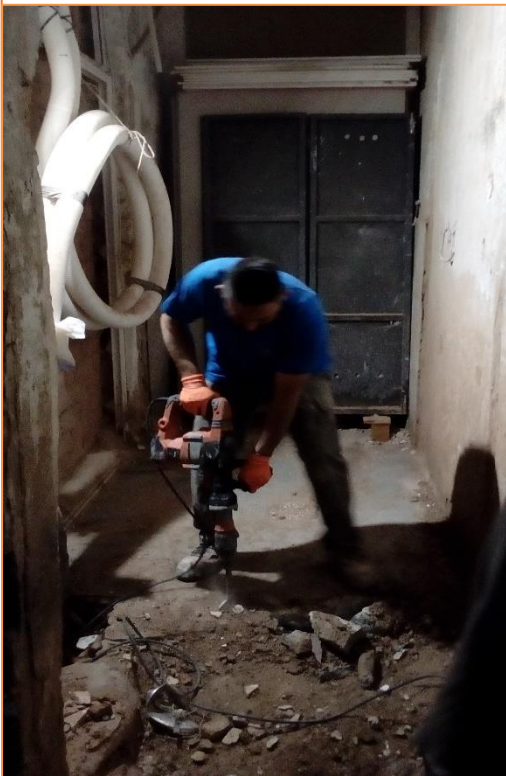
Foto 3. Punt d'inici del repicat del paviment de ciment UE 1.
