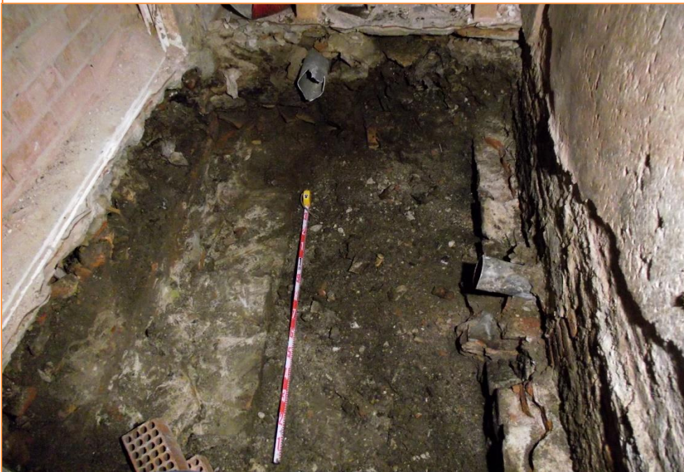
Foto 5. Localització de les riostes UE 3 i UE 4. Enmig, l'estrat constructiu UE 2.
