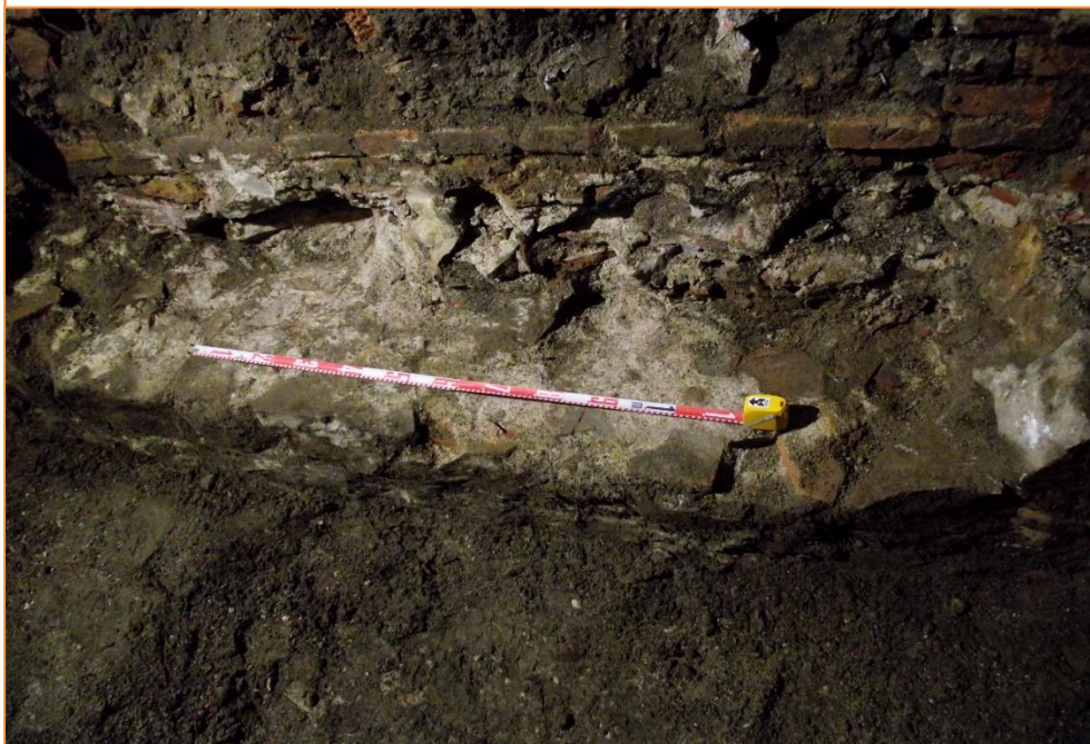
Foto 6. Vista de detall de la riosta UE 3.
