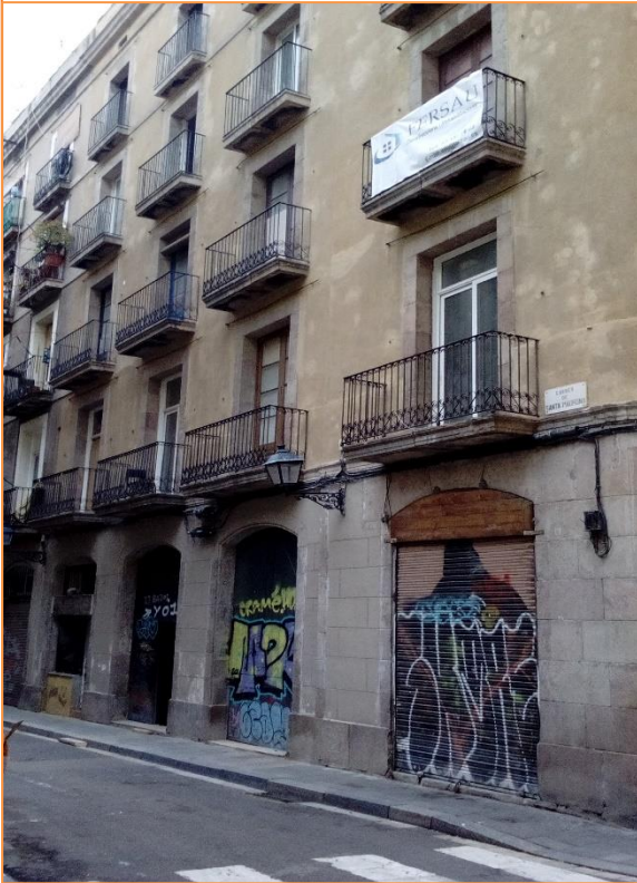
Foto 1. Façana de la finca intervinguda des del carrer Santa Madrona.
